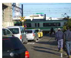
除却する前の米山踏切の様子
