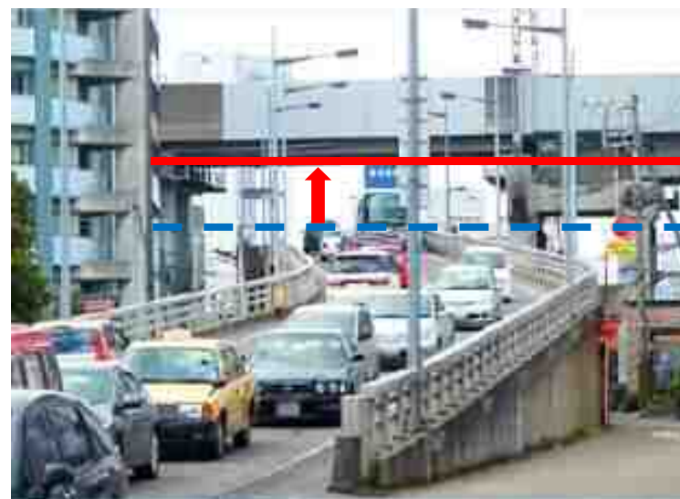
東跨線橋の状況
