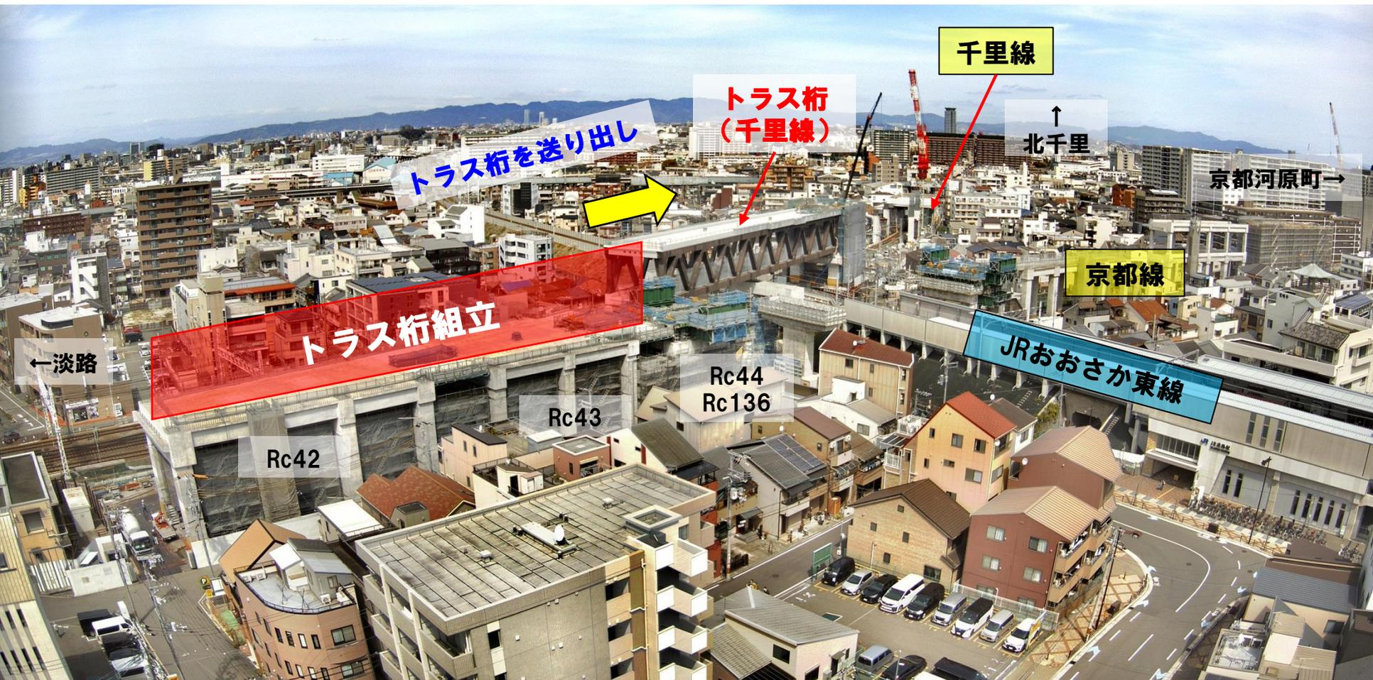
新設高架橋中層の上で、長大トラス桁を構築し、
